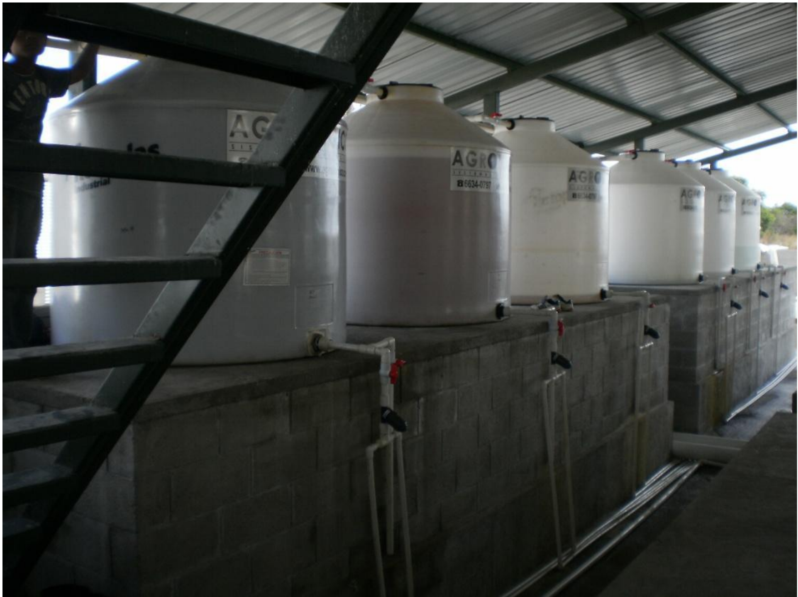
Tanques de fertilización ( 5 UNIDADES de 1000 litros cada uno.)
