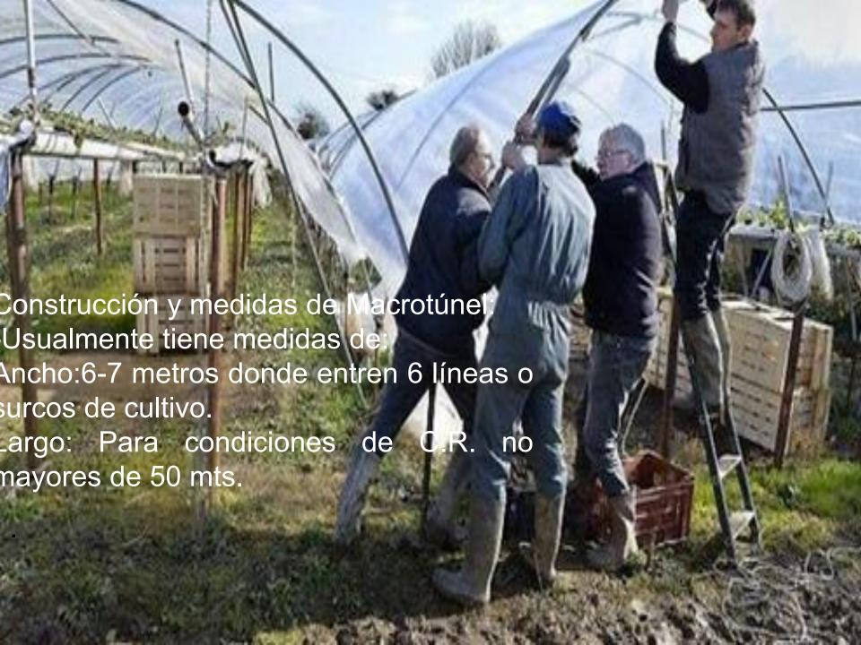
Pasos a seguir para montar un macrotúnel: 1-Instalación de soportes metálicos.
